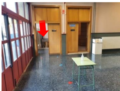
Hall distribuidor Bajada plata sótano puerta izquierda
